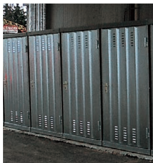
Container mit Kiemen zur Belüftung
