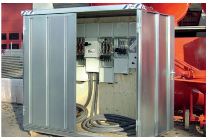
Als Einhausung für einen Stromverteilerkasten
